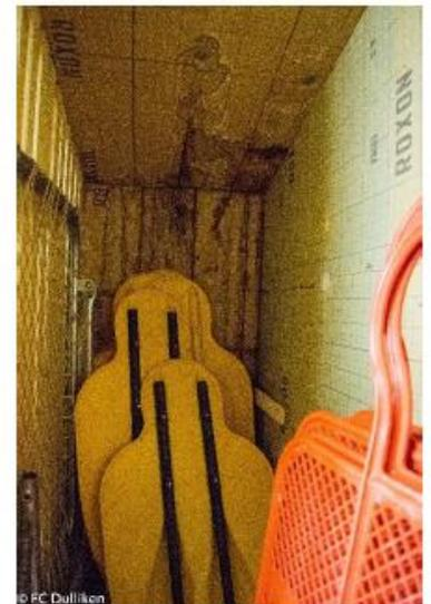
Abbildung 12&13: Ballraum: undicht stand mehrmals schon unter Wasser
